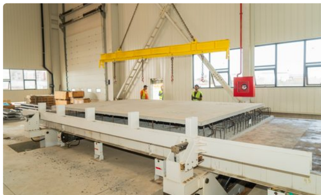
Prémur sur table de basculement, avant levage au palonnier : parement lisse de fond de moule.
